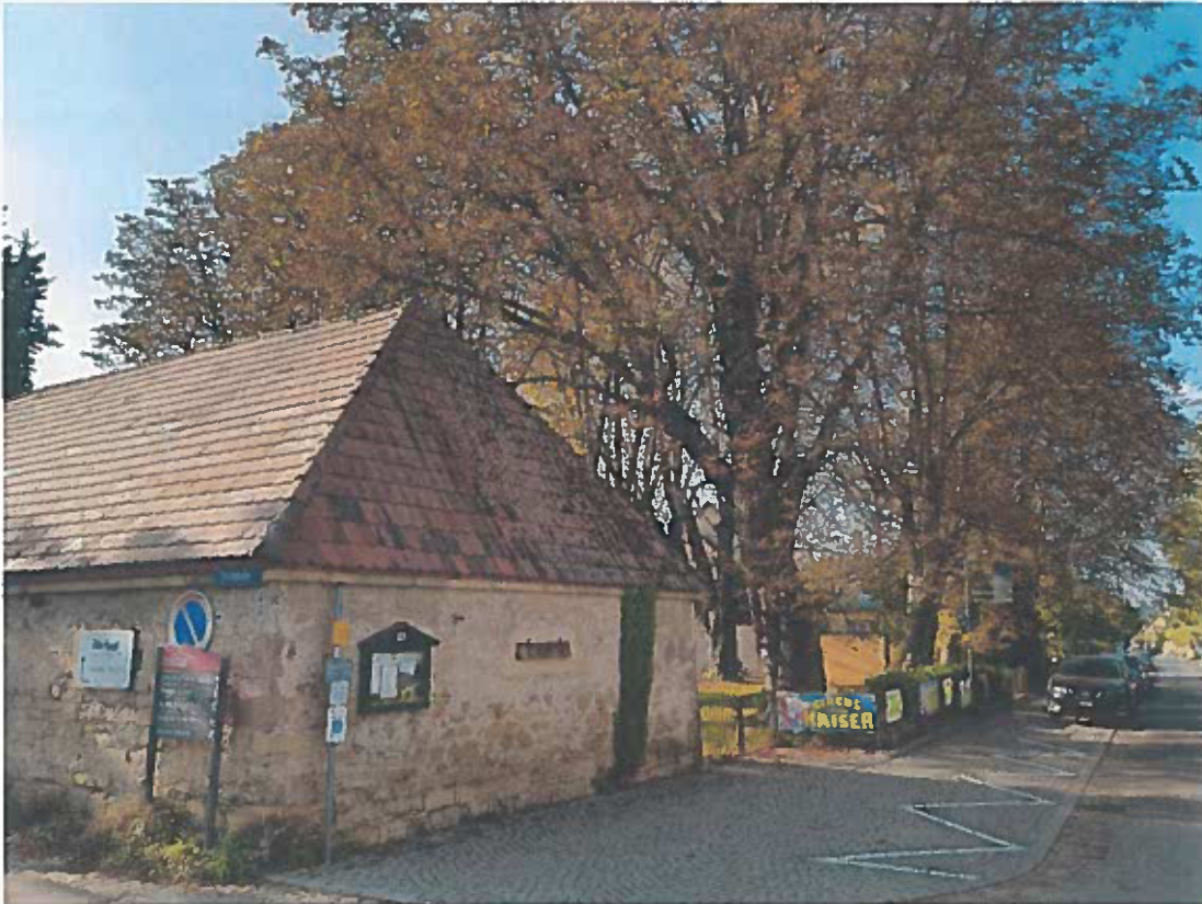
Abbildung 8: Blick auf das historische Lagergebäude mit dem stadtbildprägenden Kastanienbestand
