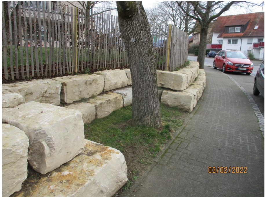
Blocksteinmauer auf dem Gelände der Schule
